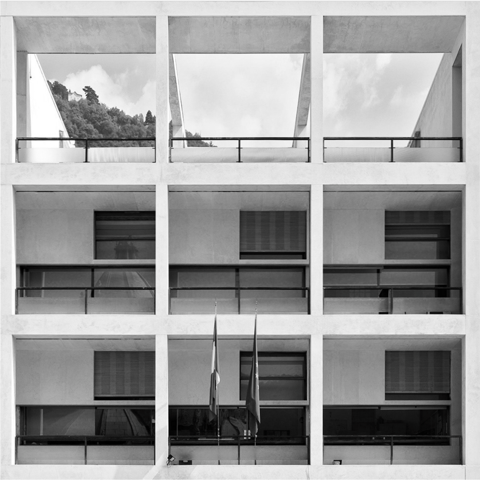
Fig. 2 : Architecture tectonique. CANO Enrico, Photographie de la Casa del Fascio de Giuseppe Terragni.
